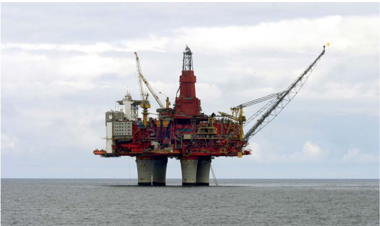
Abbildung 16: Plattform zur Förderung von Erdöl und Erdgas über dem Norwegischen Kontinentalschelf in der Nordsee (Bild: www.statoil.com ).
