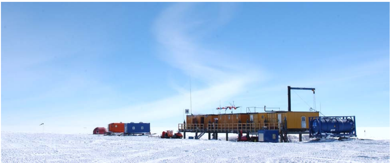
Abbildung 2: Eisstation Kohlen DES ALFRED-WEGENER-INSTITUTS FÜR POLAR- UND MEERESFORSCHUNG (AWI), Dronning Maud Land, Antarktis (2003). Die Station ist auf Stahlträgern eingehangen und kann je nach Schneezutrag angehoben werden. (Bild: AWI)
